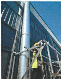
印刷废气、润版废弃、擦拭废气 排气筒出口
