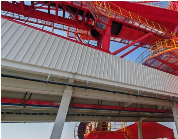
码头封闭隔音输送廊道
