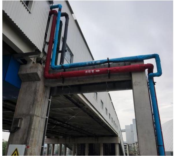
船舶废水转移管线
